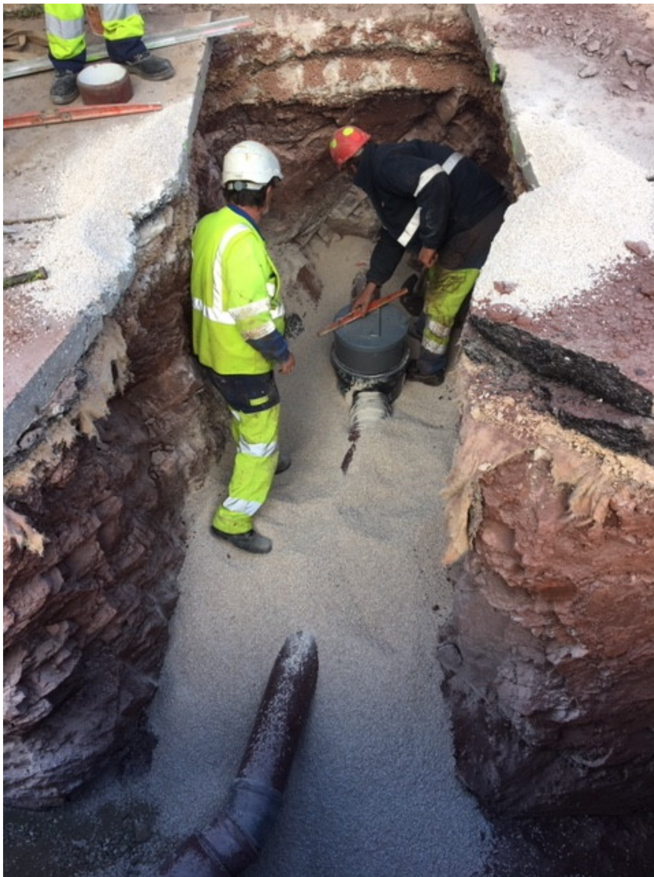
Dans le cadre des travaux sur le réseau d'assainissement, Métropole Toulon Provence
