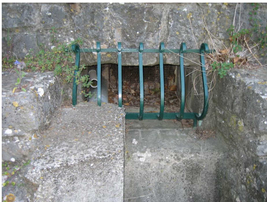
Grille à modifier et tuyau à enlever
