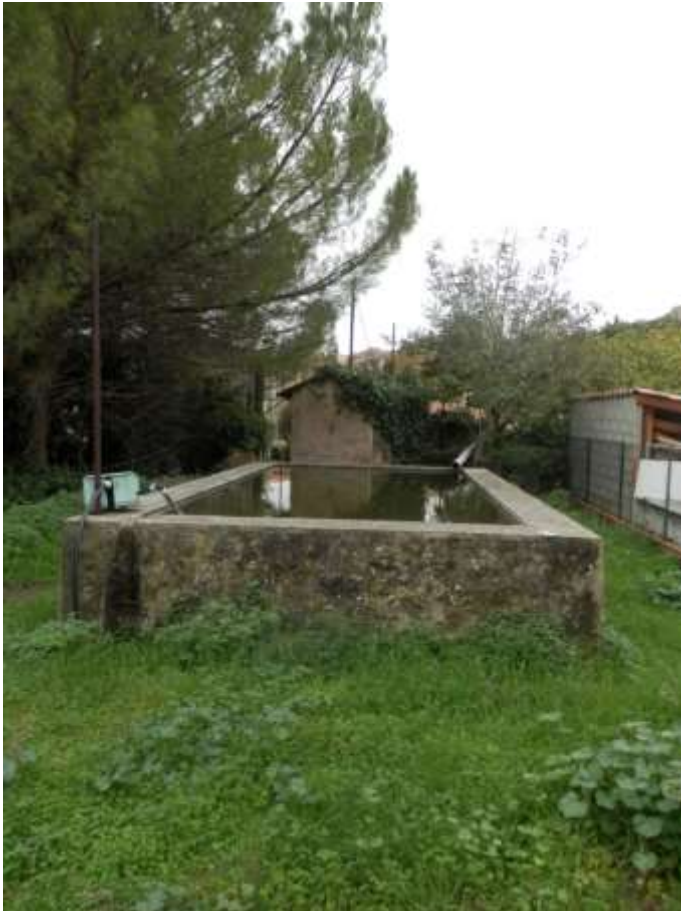
Bassin d'irrigation et canal d'amenée d'eau au sorti du local de la pompe mécanique.
