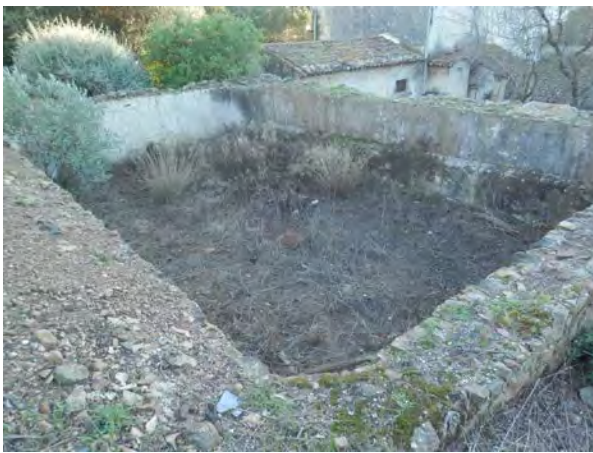
A l'arrière des communs, grand bassin d'irrigation, installé en hauteur afin de permettre l'irrigation par gravité.
