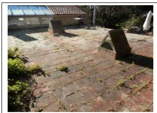
Toit de la citerne à l'arrière de la villa constitué de dalles de céramique « pan carra ».
