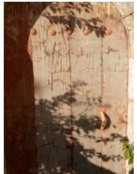
La porte qui communiquait avec les communs a été bouchée par une maçonnerie sur laquelle a été peint un trompe-l'œil figurant la porte de bois.
