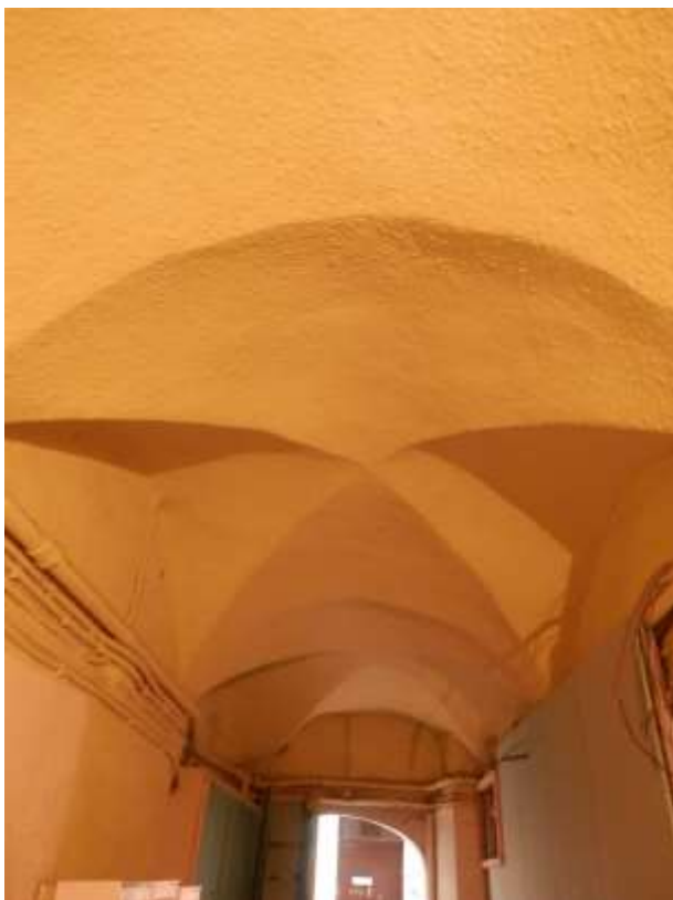
Croisée de voûte du couloir au rez de chaussée.
