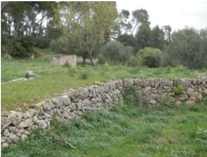
A l'ouest des communs, une aire ronde aménagée en podium est desservie par deux rampes d'accès charretières, selon un axe est-ouest. Le podium est retenu par un mur de soutènement de pierres calcaires sèches. Sur la partie nord de l'aire, un puits ouvert a été creusé.
