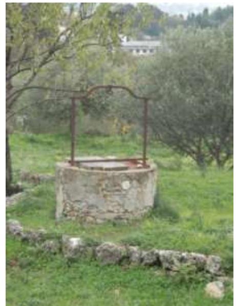
A l'ouest des communs, une aire ronde aménagée en podium est desservie par deux rampes d'accès charretières, selon un axe est-ouest. Le podium est retenu par un mur de soutènement de pierres calcaires sèches. Sur la partie nord de l'aire, un puits ouvert a été creusé.
