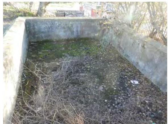
A l'arrière des communs, grand bassin d'irrigation, installé en hauteur afin de permettre l'irrigation par gravité.
