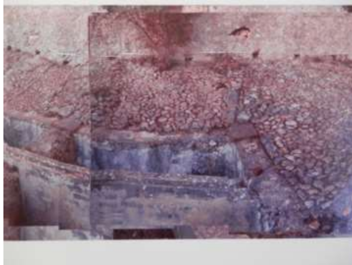
Caladage de galets permettant la récupération de l'eau de ruissellement et son stockage dans un bassin, au premier plan.
