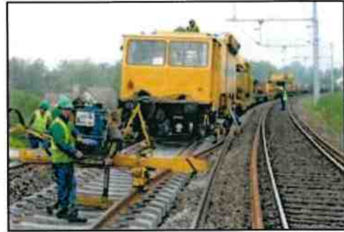
Longs Rails soudés sur traverses béton
