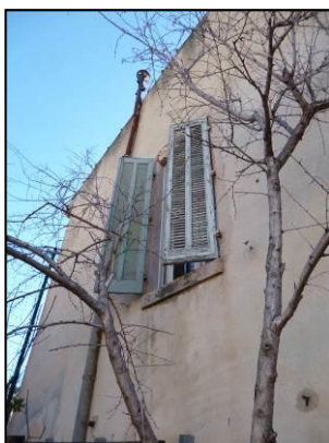
Menuiseries bois anciennes insuffisantes en isolation thermique et étanchéité à l'air
