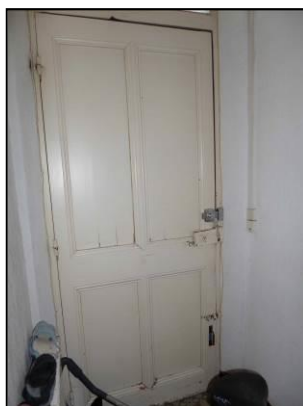
Menuiseries bois anciennes insuffisantes en isolation thermique et étanchéité à l'air
