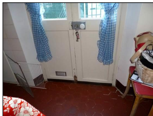
Menuiseries bois anciennes insuffisantes en isolation thermique et étanchéité à l'air
