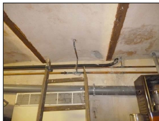
Cave en sous-sol - plancher en voûtains – présence de fuite au droit des sanitaires
