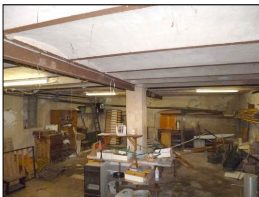
Cave en sous-sol - plancher en voûtains – présence de fuite au droit des sanitaires
